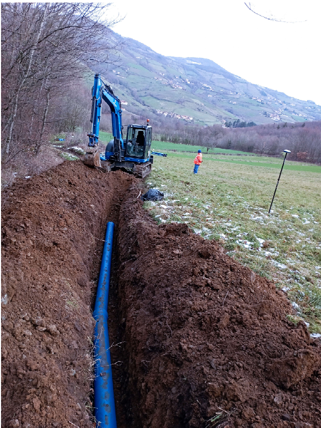
Pose de canalisations et borne en février 2023 (Tranche 2)
